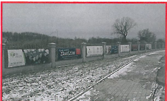
Fot. 47a i 47b. ul. Polna Droga – przed i po
