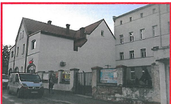
Fot. 35a i 35b. ul. M. Konopnickiej – przed i po
