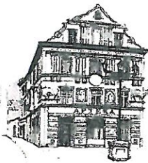
Kamienica „Pod Bykami” Kamienica „Pod Bykami”
