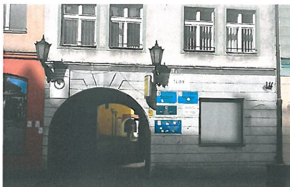
Fot. 4. Elewacja w części uporządkowana – rok 2017
